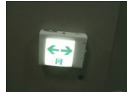
통로유도등이 올바르게 설치된 경우
